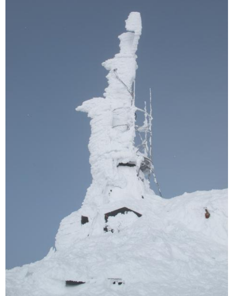
Station de mesures du Säntis complètement enveloppée par le givre. Photo : Giovanni Converso, 26 janvier 2012.
