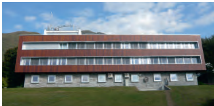
Le centre de prévision à Locarno-Monti a été rénové selon le standard Minergie.
