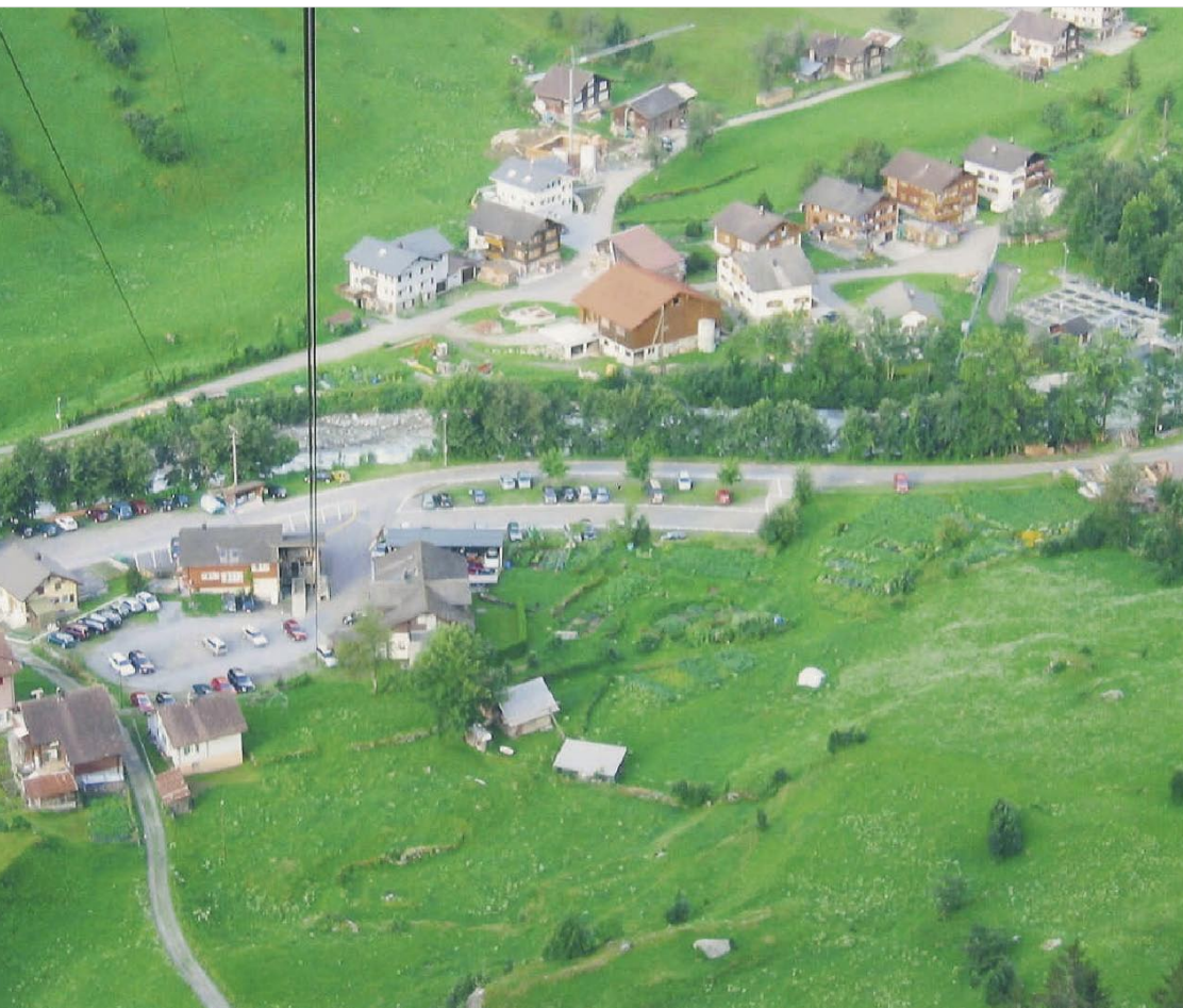
▲ Bristen (UR) vor dem Hochwasser-Ereignis im August 2005, Bild: André Guntern (ARP Uri).
