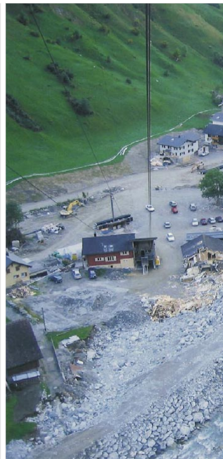
▲ Bristen (UR) nach dem Hochwasser-Ereignis im August 2005, Bild: Heinz Baumann (Baumann & Fryberg, Altdorf).
