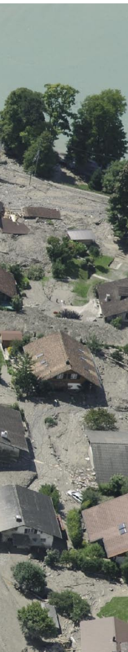
◀ Abbildung 1.1: Schäden eines Murgangs in Brienz (BE) nach dem Starknieder- schlagsereignis August 2005.
