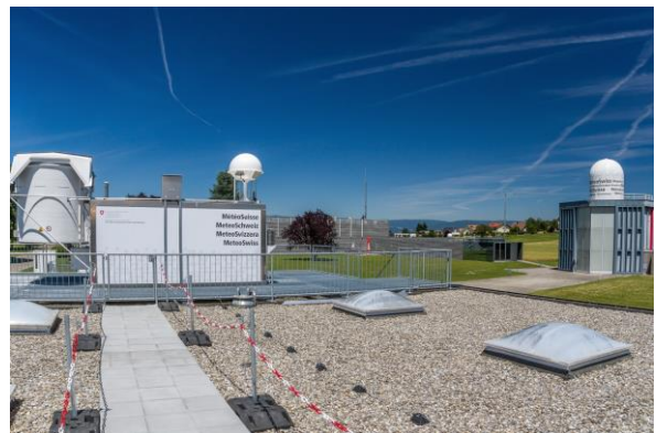
Le robot pour le lancer automatique des radiosondes à gauche et la halle de gonflage pour les radiosondages experts à droite.
