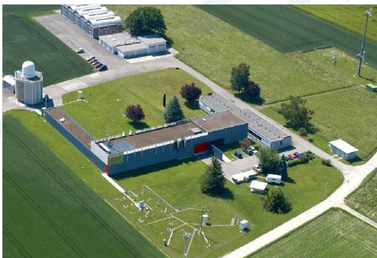
Vue aérienne de la station aérologique de Payerne en 2003. Au centre, le nouveau bâtiment terminé en 2002.
