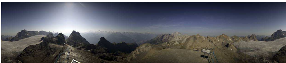
Vue sur le nouveau site radar en Valais : la Pointe de la Plaine Morte.
